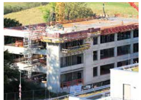
Das im Bau befindliche Bildungszentrum.
